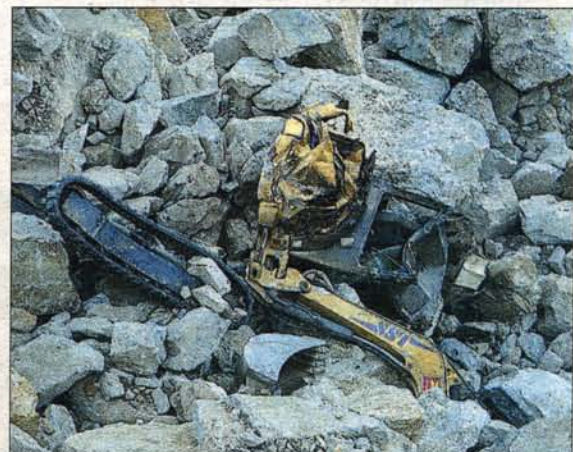
Da lag der Bagger unten. Zum Glück saß niemand drinnen. FOTOS: SOMMER
